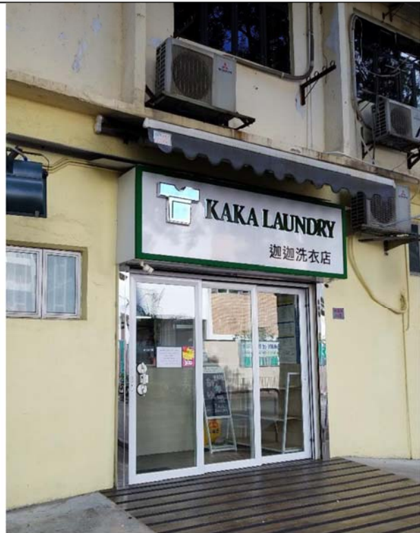
Front portion, 54 Ngan Hon Street
